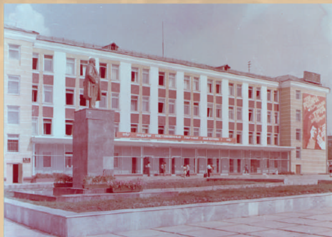
Здание заводоуправления. нач. 1980-х гг.
